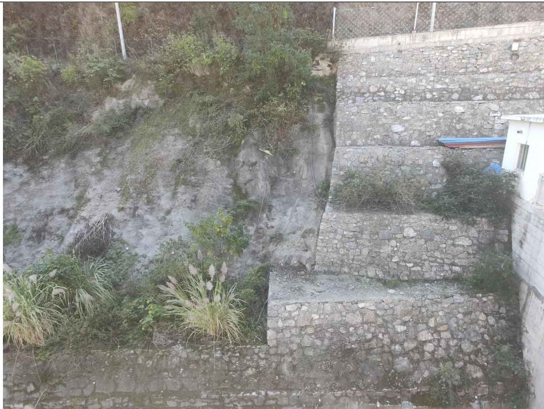
边坡喷护及浆砌石拦挡
