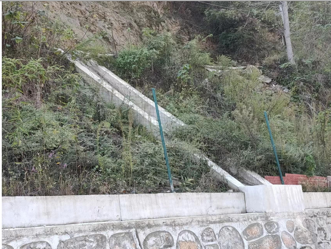
浆砌石护坡及排水沟、边坡绿化
