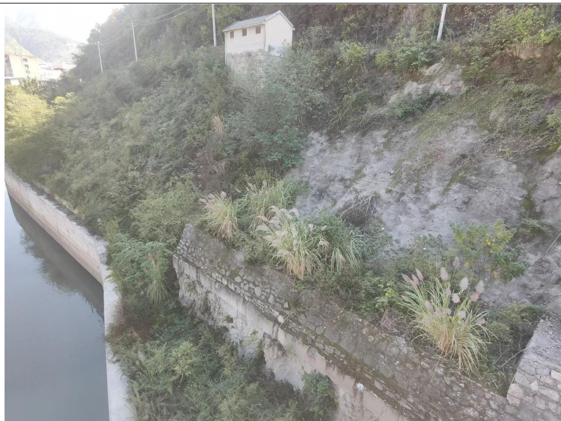
边坡喷护及浆砌石拦挡
