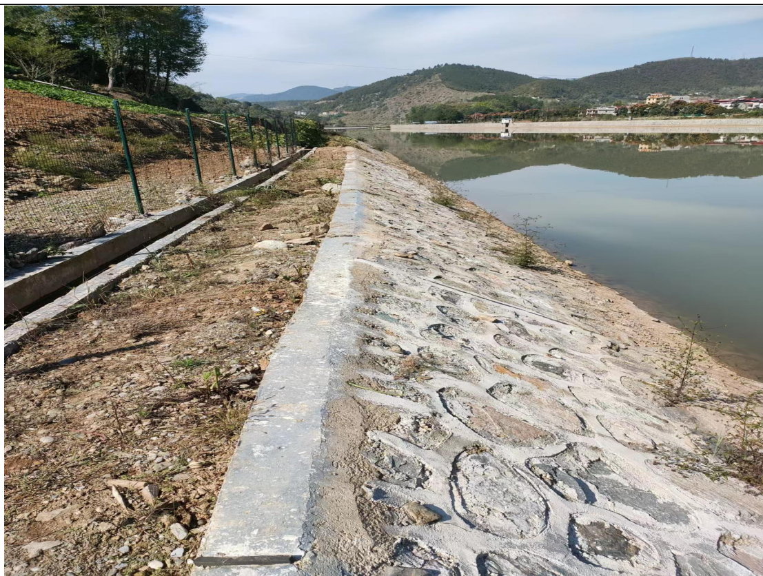
浆砌石护坡及排水沟
