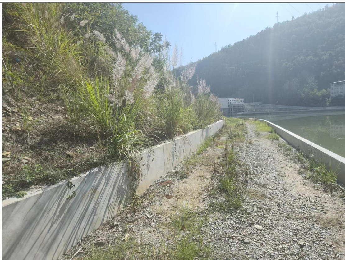
浆砌石拦挡及边坡绿化
