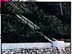
排水沟及边坡拦挡
