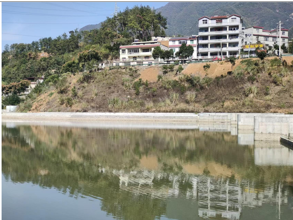
浆砌石拦挡及边坡绿化
