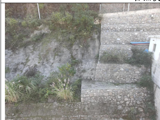
浆砌石拦挡及边坡喷护
