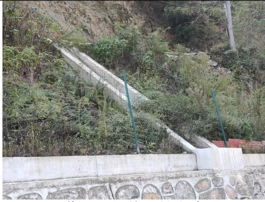
浆砌石拦挡及排水沟
