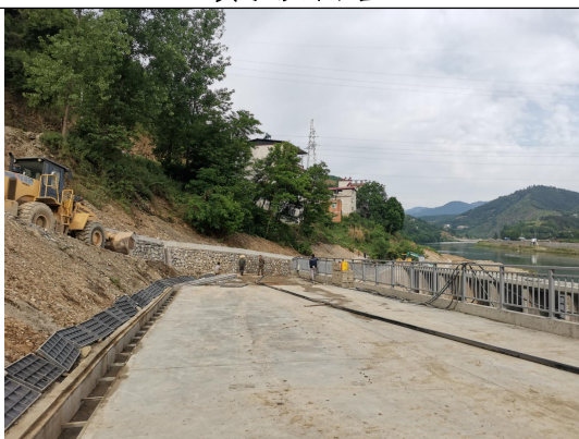
场地硬化及排水沟
