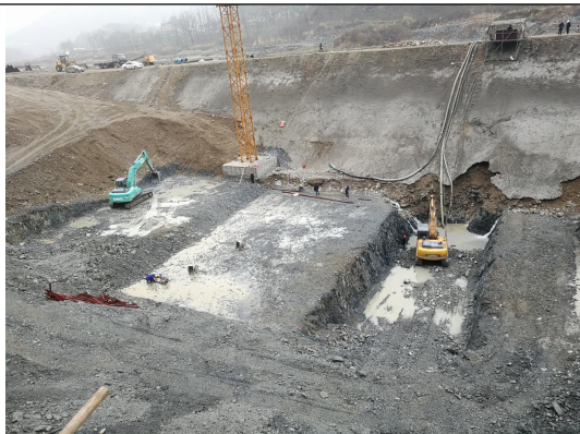
主体工程修建
