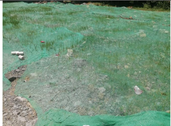
临时占地绿化及苫盖
